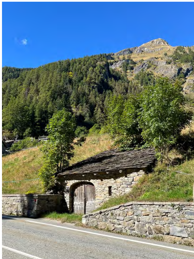
Figura 4.7 - Manufatto con copertura paravalanghe in Pré-Saint-Didier, Valle d'Aosta (Frigo, 2024).
