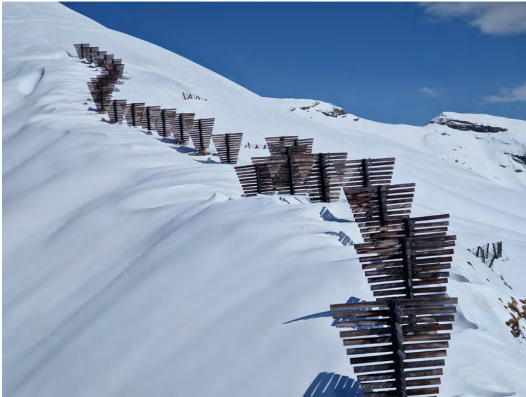
Figura 4.5 – Frangivalenti a croce (o ad albero rovesciato) posti nella zona di cresta del bacino valanghivo di Lavanchers in Morgex, Valle d’Aosta (Segor, 2024).
