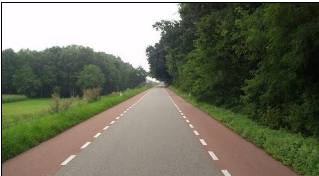
Esempio di strada extraurbana a prevalente uso ciclabile (i pittogrammi possono sostituire la colorazione)
