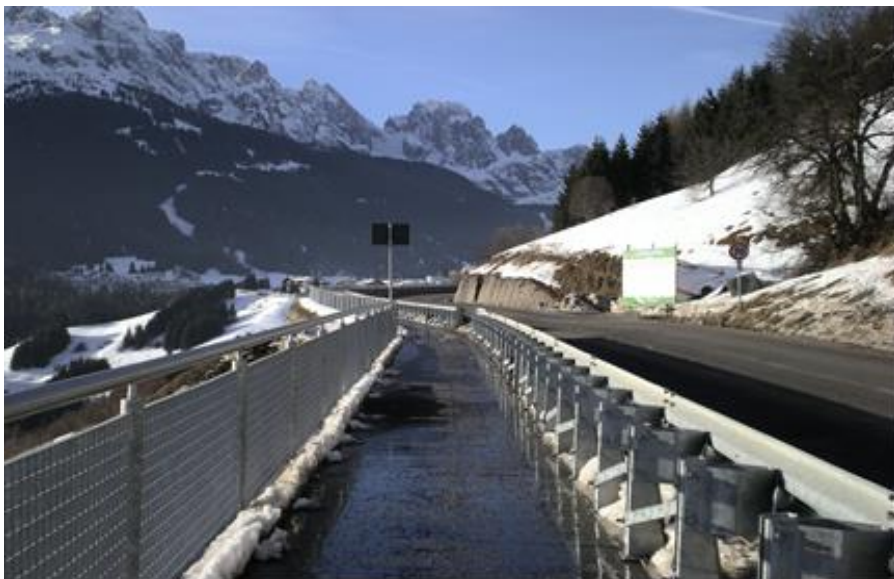
FOTOGRAFIA DELLA PASSERELLA PEDONALE – IN DIREZIONE NORD, VERSO L'ABITATO DI DOSSOLEDO
