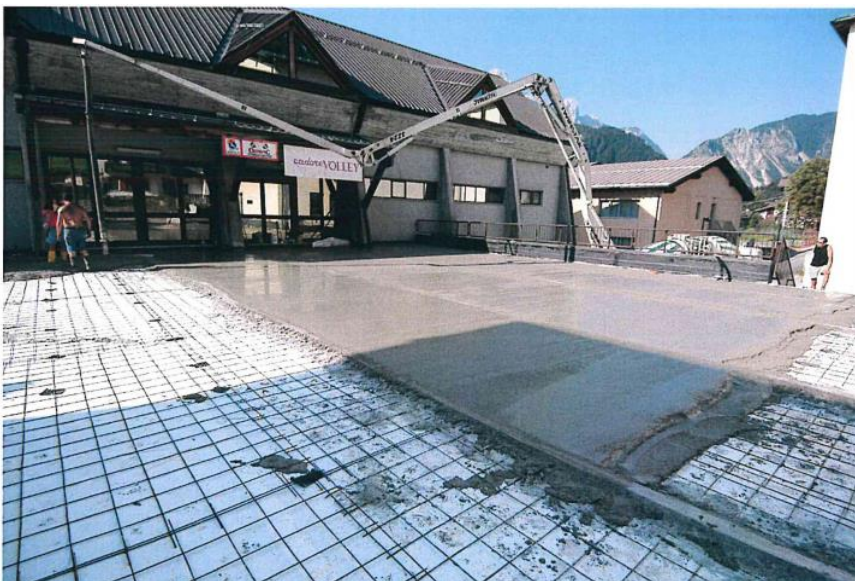
PARTICOLARE GETTO DEL MASSETTO DI RICOPRIMENTO GUIANA
