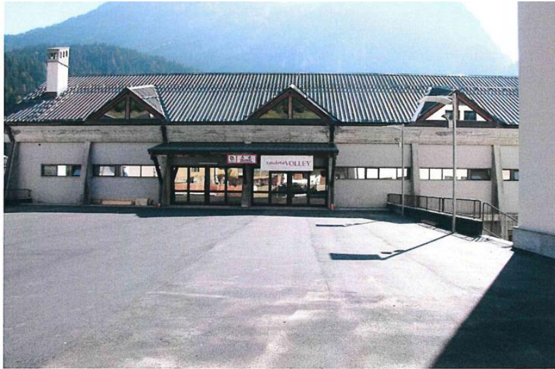
VEDUTA DEL PARCHEGGIO ULTIMATO
