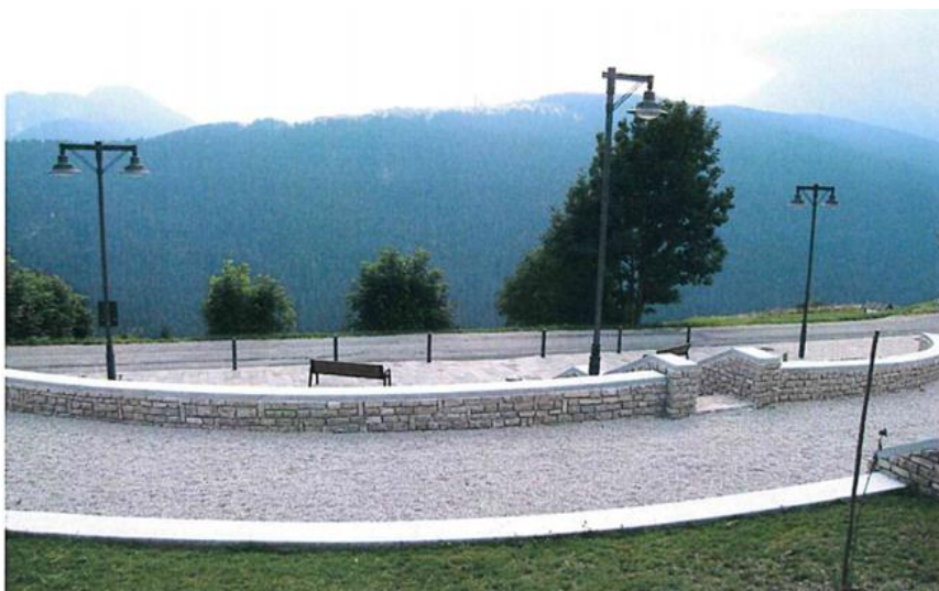
VISTA DALL'ALTO DELL'AREA: SI NOTI LA SISTEMAZIONE A GRADONI CON GHIAINO ED ERBA ED I PALI DELL'ILLUMINAZIONE PUBBLICA
