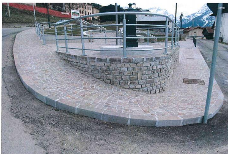
PARTICOLARE ANGOLO DELLA STRUTTURA CON EVIDENZIATO IL MARCIAPIEDE IN CUBETTI DI PORFIDO E LE CORDONATE
