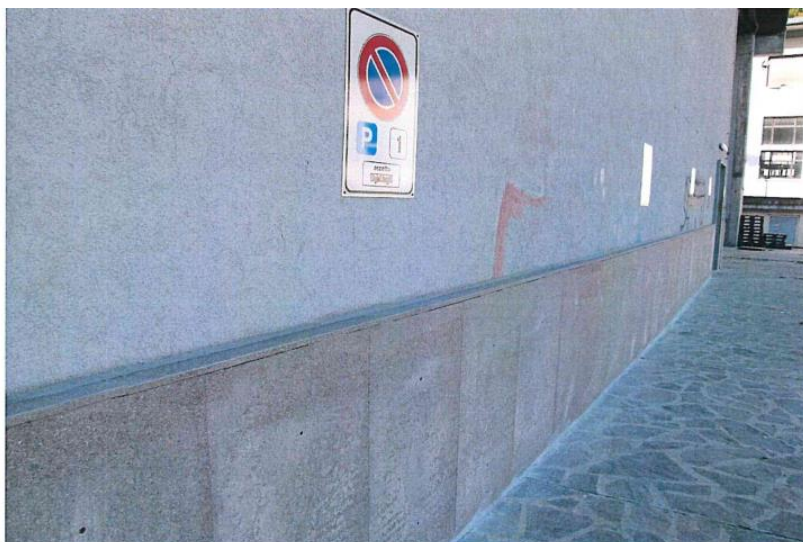
PARTICOLARE RIVESTIMENTO LASTRE IN PORFIDO
