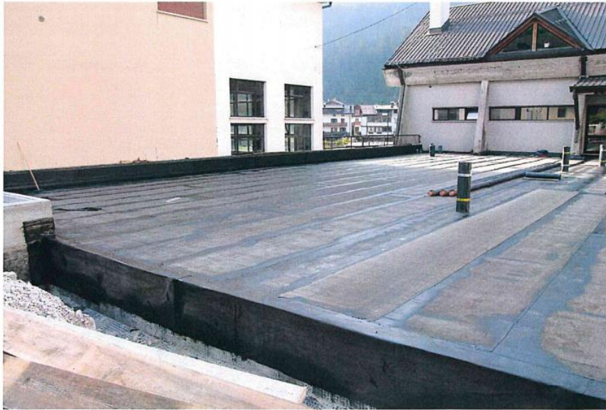
PARTICOLARE POSA DELLA GUIANA SUL MURETTO
