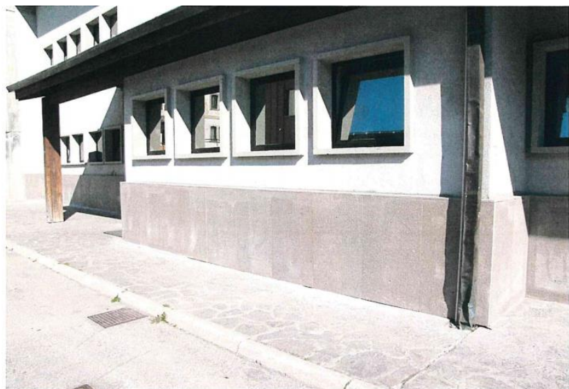
PARTICOLARE RIVESTIMENTO LASTRE IN PORFIDO
