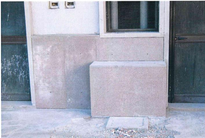
PARTICOLARE RIVESTIMENTO LASTRE IN PORFIDO
