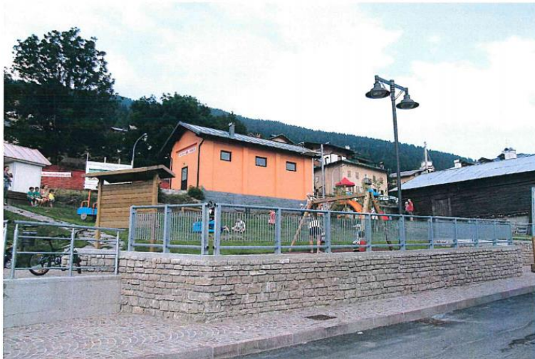
VISTA DAL BASSO DELL'AREA, SI EVIDENZIA LA REALIZZAZIONE DEL PARCO GIOCHI
