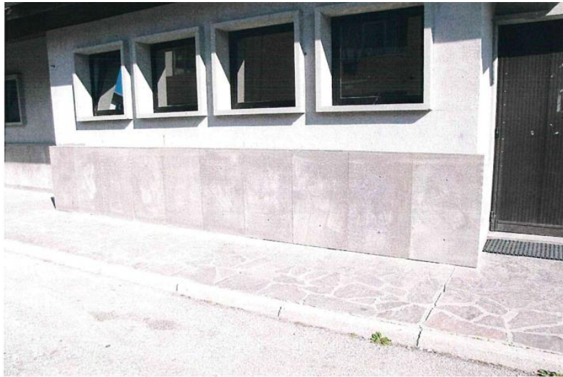
PARTICOLARE RIVESTIMENTO LASTRE IN PORFIDO
