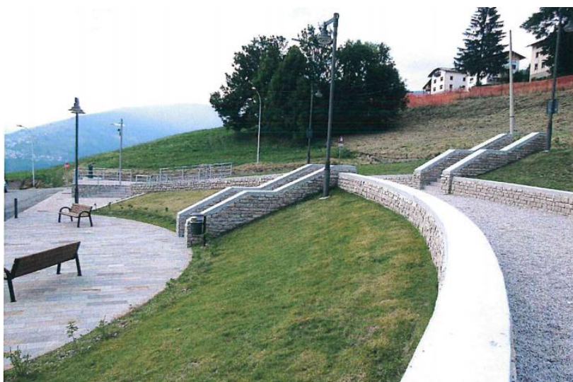
VISTA DALL'ALTO DELL'AREA: SI NOTI LA SISTEMAZIONE A GRADONI CON GHIAINO, ERBA, I PALI DELL'ILLUMINAZIONE PUBBLICA E LE PIASTRE IN PORFIDO
