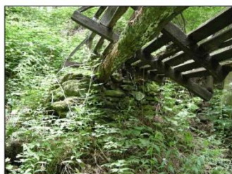
Vista da monte spalla sinistra
