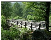
Vista passerella da sponca sinistra
