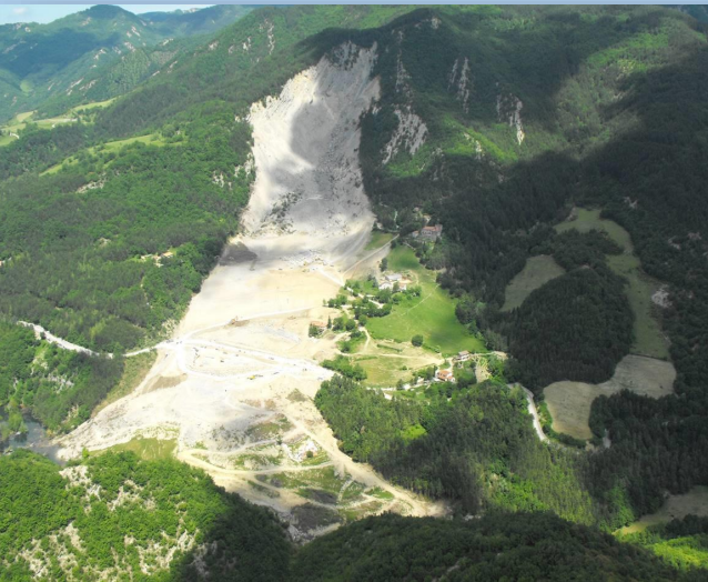
Frana di Poggio Baldi
